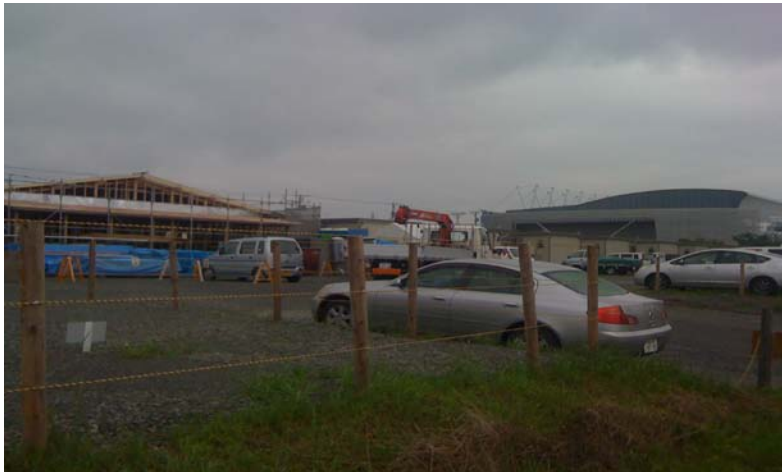
左は建設中の仮診療所、右はビッグパレット
