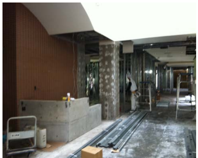
修復中の1F部分
